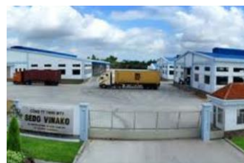
Nhà máy Sedo Vinako Sedo Vinako Plant
