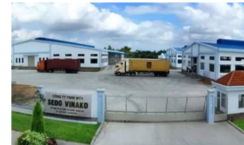
Nhà máy Sedo Vinako Sedo Vinako Plant
